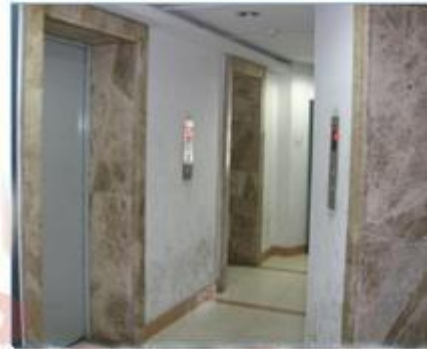
内蒙古某社区电梯五方对讲
