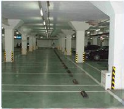
某停车场对讲系统
